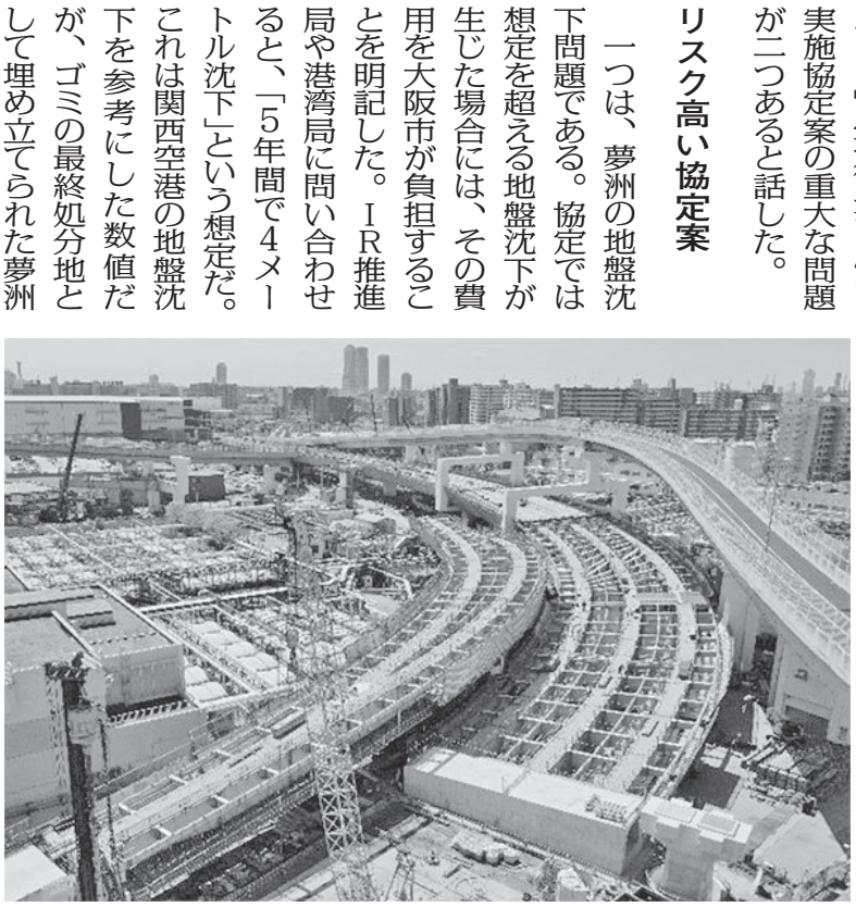
阪神高速淀川左岸線2期工事＝海老江下水処理場付近(大阪市此花区)／阪神高速道路のウェブサイトより転載
