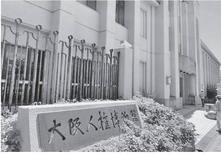
2020年5月末に閉館した大阪人権博物館(リバティおおさか)、21年に建物も完全に解体された。
