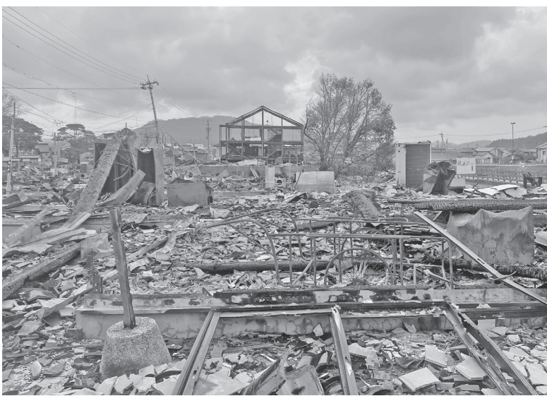
樹木だけが残った瓦礫のまち=石川県輪島市、4月上旬
